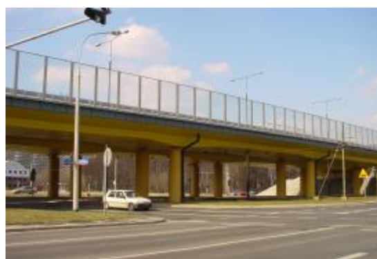
Lekkie ekrany przezroczyste na wiadukcie
